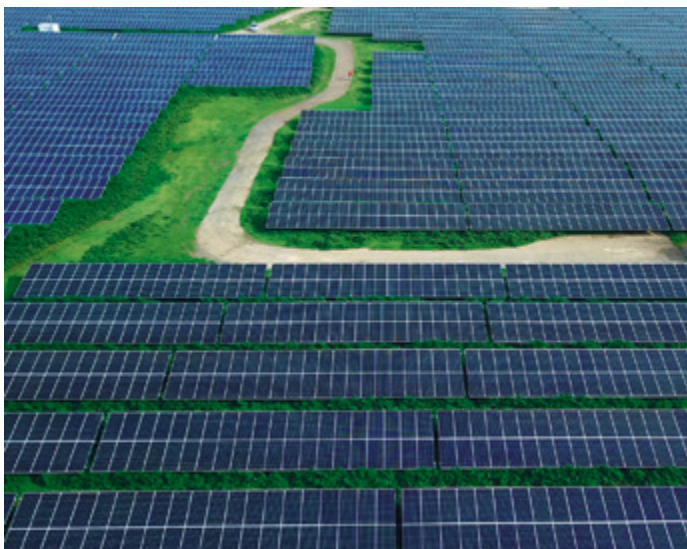
Auf der ehemaligen Aschedeponie erzeugt Sachsen-Anhalts größter Solarpark „Phönix“ pro Jahr bis zu 12.000 Megawattstunden Sonnenstrom. Diese decken den Energiebedarf von etwa 3.000 Haushalten.
