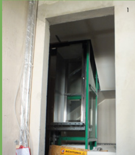
1. Aufzugseinbau im Oleanderweg
