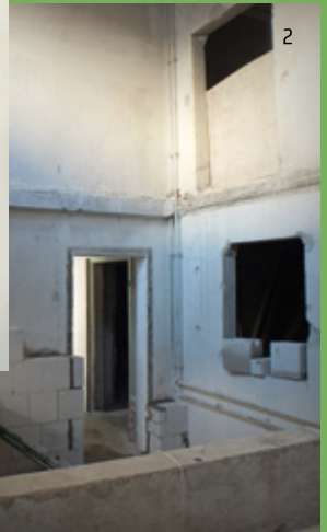
2. Baustelle vor Einbau
